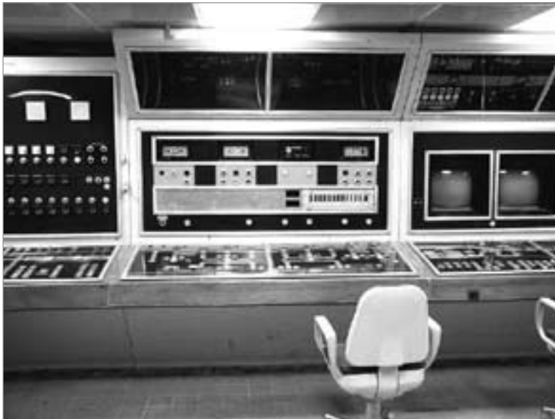
Regierungsbunker der BRD in Marienthal bei Ahrweiler – Kommandozentrale, von der aus die Bundesregierung 1966 den „Ernstfall“ probte
