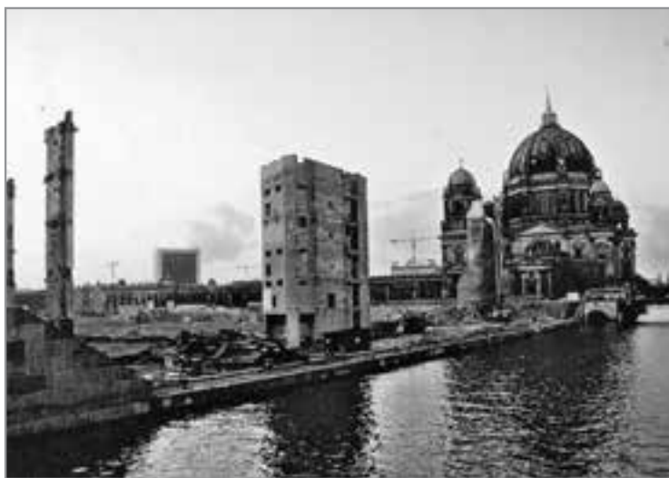
Letzte Reste des abgerissenen Palasts der Republik am Berliner Spreeufer
