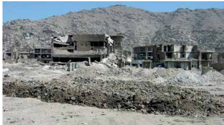
Zerstörte Häuser in Kabul 2004
